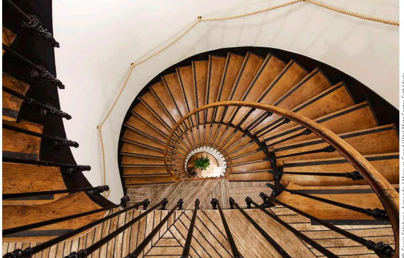
L'escalier comme la façade sont classés Bâtiment de France
