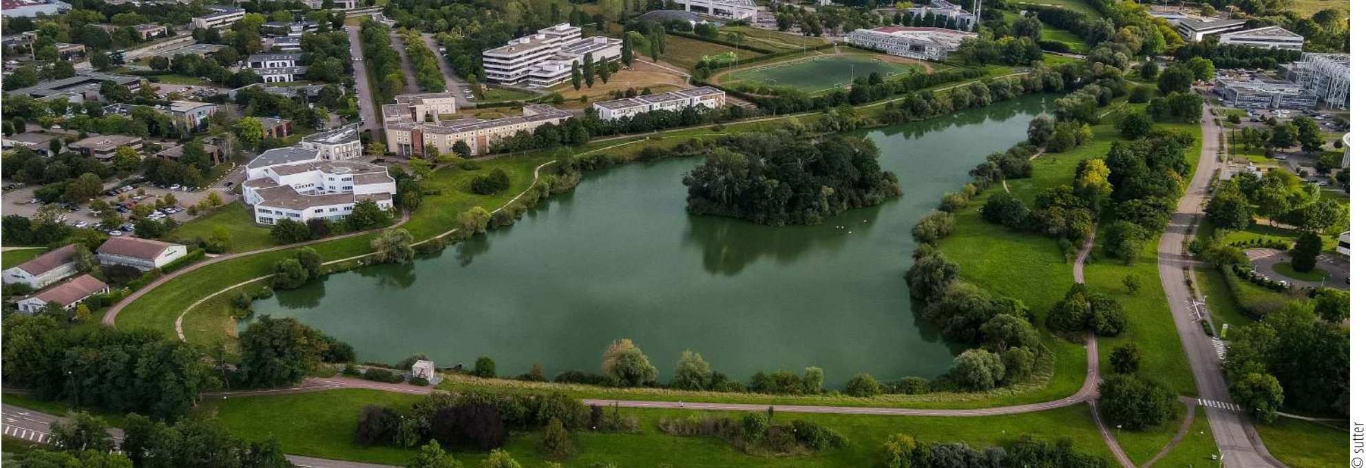
Metz-Technopôle s'étend sur 180 hectares articulés entre entreprises, grandes écoles et instituts de recherche
