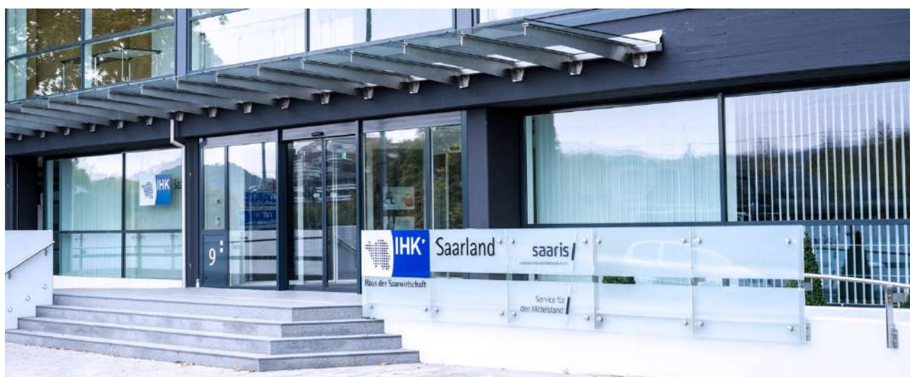
Locaux du WTC Metz-Saarbrücken à l'IHK Saarland à Sarrebruck © Droits réservés
