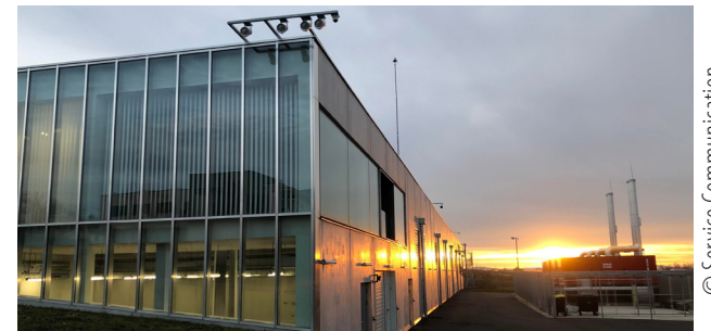
Le data center de Peltre emploie à ce jour 9 personnes dans ses locaux
